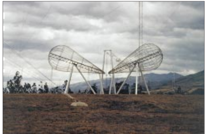
Auf Schienen kann diese Antenne in die gewünschte Richtung gedreht werden, um die bis zu 500 kW Sendeleistung abzustrahlen.
